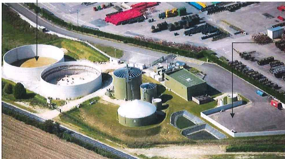
Fig. n° 47 : Vue aérienne du site BIOGAZ de Gaillon
